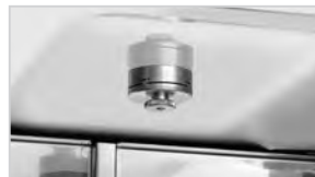
▶ Dampfgeneratoren: Direkteinspritzung
